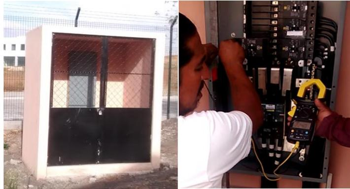
Se colocó la base y un escalón en el acceso que da al medidor de luz de la escuela, ya que personal de la CFE no quería tomar lectura debido a las condiciones inseguras por la humedad.
